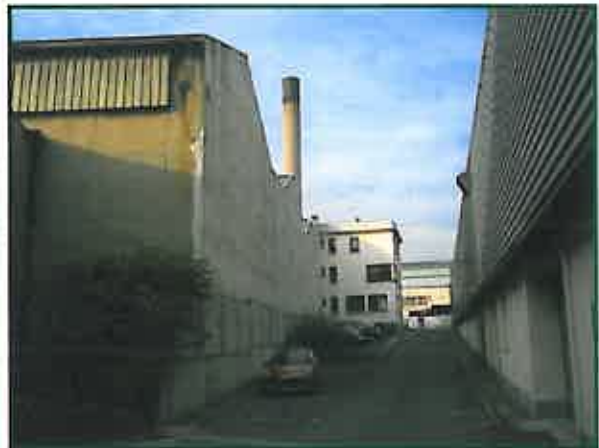
Voirie intérieure du site
