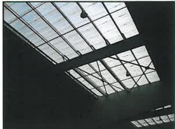
Charpente du nouvel entrepôt construit
