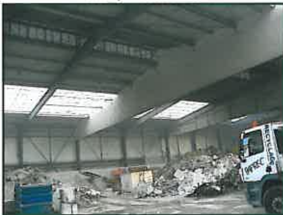
Nouvel entrepôt construit
