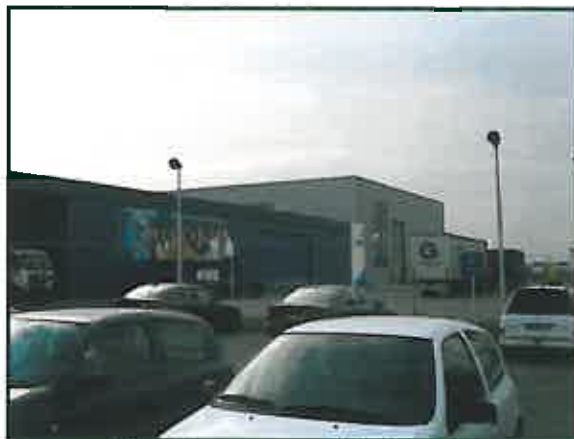
Façade et vue sur l'extension
